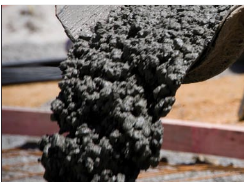
In Nederland wordt jaarlijks 16 miljoen kuub beton verwerkt. De wereldconsumptie van cement bedroeg in 2006 2,283 miljard ton, waarvan liefst 1,2 miljard ton ofwel 45 procent in China.
