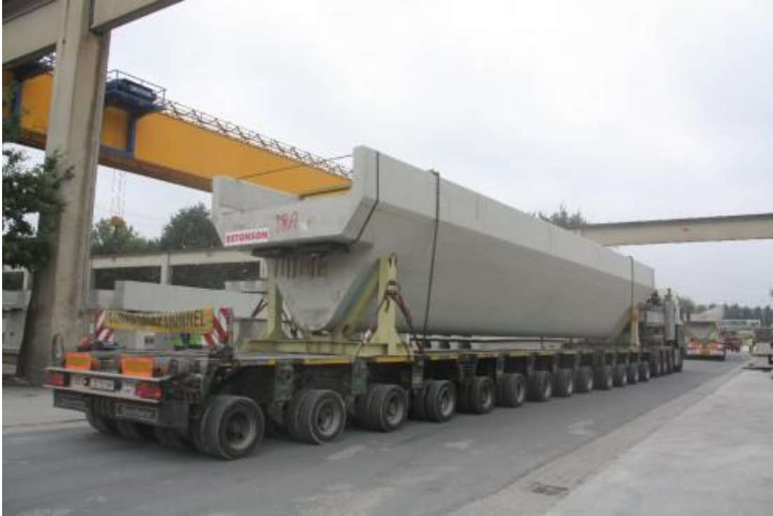
Figuur 1.1: Voor de snepbrug bij Gent zijn 54 van deze brugliggers ontworpen.
